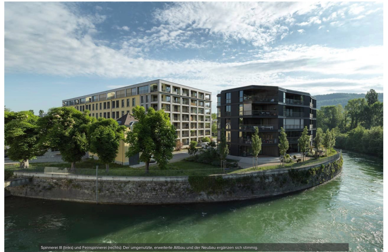
Spinnerei III (links) und Feinspinnerei (rechts); Der umgenutzte, erweiterte Altbau und der Neubau ergänzen sich stimmig.
