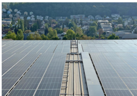
Anlage der HIAG Solar in Brunegg
