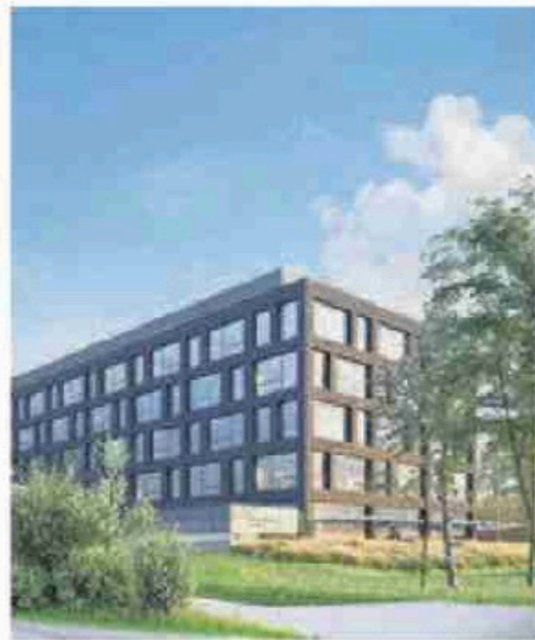
Grosse rénovation en cours dans la zone de Meyrin. DR
