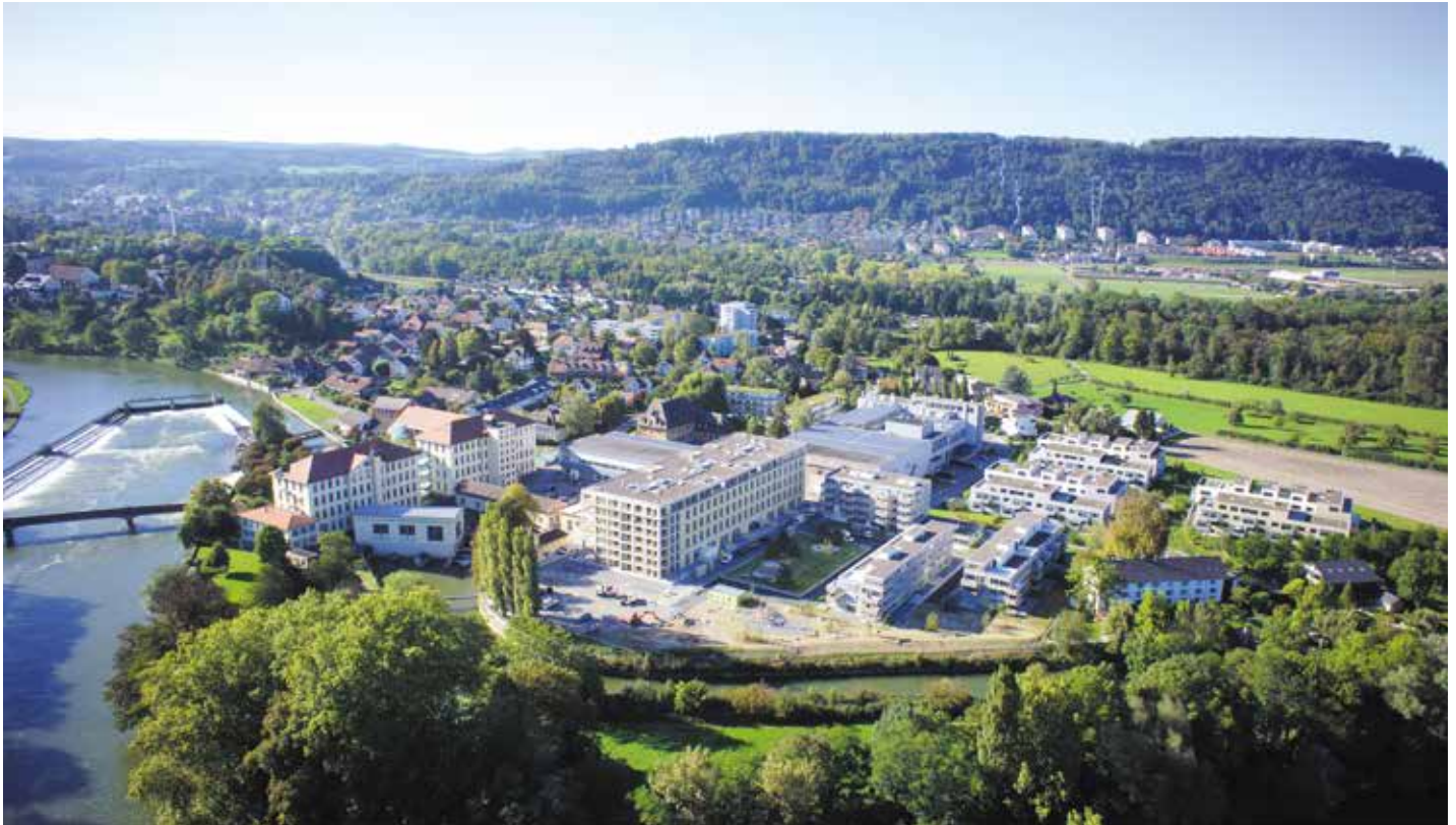
Das Kunzareal in Windisch AG an der Reuss umfasst rund 48 000 m 2 . Der Industrieort wird zu einem Quartier mit gemischter Nutzung (Bilder: Hiag AG).
