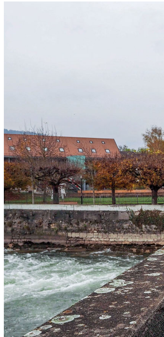
Das Kunzwerk ist Teil des Spinnereiareals, das in den Das Gebiet liegt auf einer Halbinsel, die von der Reuss,
