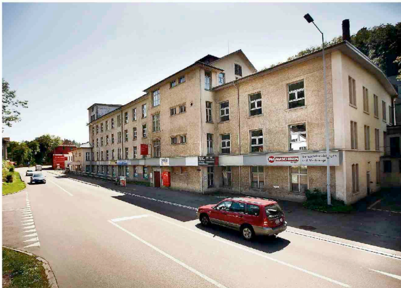
Die ehemalige Spinnerei Oberaathal soll saniert werden. In den Dachgeschossen sind Loftbüros geplant. Foto: Nicolas Zovli
