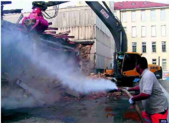
Das Kesselhaus wird in diesen Tagen als erster Altbau beseitigt.
