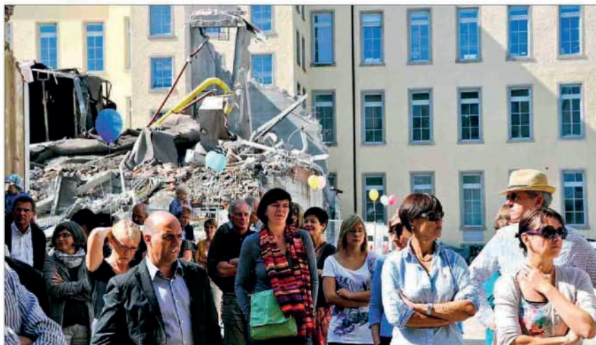
Hinten die alte Spinnerei, die vor zehn Jahren in Lofts umgebaut wurde, davor das abgerissene Heizungsgebäude Bild: cl
