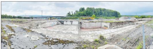
(Monique Rijks / Reg) – Derzeit lässt die Hiag auf ihrem 75'000 Quadratmeter grossen Areal (Bild oben) alte Eingänge ins Kellergewölbe aus dem Boden graben, Betonwände abreißen und Vertiefungen zuschütten. Parallel dazu wird auch das gesetzliche Fundament für die Zukunft des Campus' Reichhold gelegt. Über diese gibt Alex Römer, der Arealentwickler der Hiag, gerne vor Ort Auskunft (siehe Kasten rechts).
