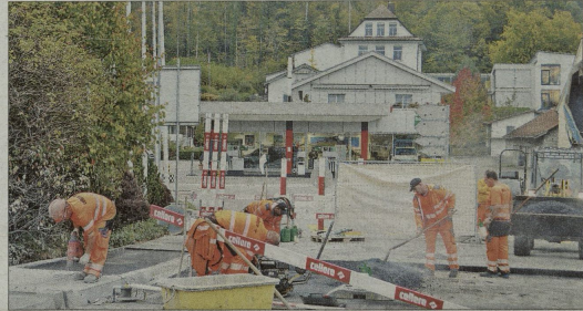
Die Bauarbeiter teeren ein letztes kleines Stück Strasse vor dem «Rössli»-Kreisel.
