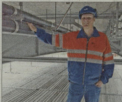
Projektleiter Peter Widmer zeigt unter der Brücke auf die Rohre mit den Telekommunikationskabeln.
